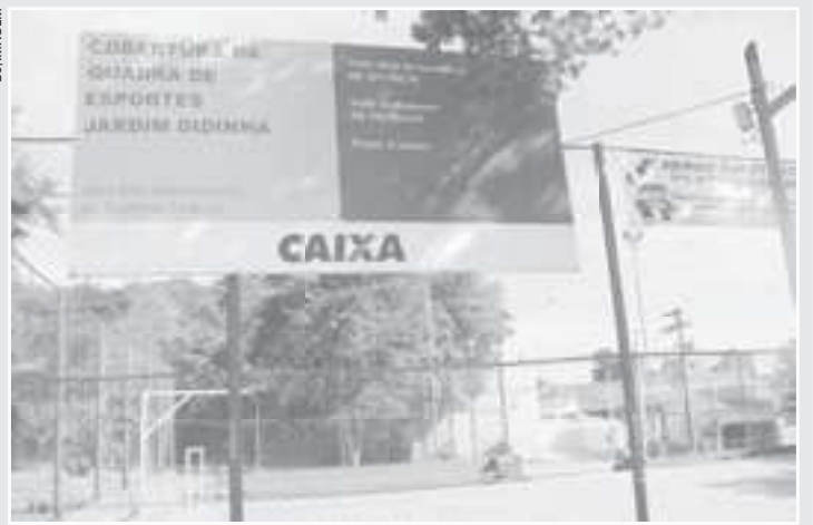
A placa publicitária instalada na quadra não informa a empresa responsável, mas apenas dados financeiros da obra
