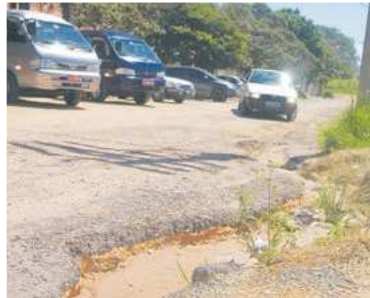
Segundo munícipes, os buracos formados pela ação do tempo e pelo tráfego de veículos na rua Ivone Lúcia Guarnieri Stock já causaram alguns acidentes
