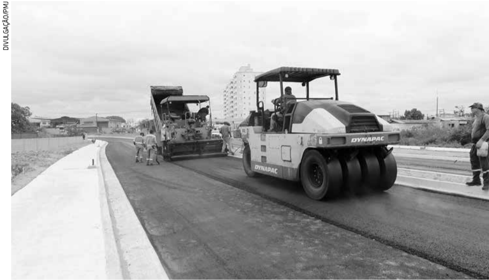
Funcionários trabalham na conclusão de guias, sarjetas e asfalto do acesso à terceira ponte
