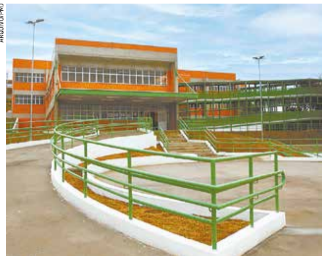
Vista externa do campus do Instituto Federal de Educação, Ciência e Tecnologia de São Paulo, em Jacareí
