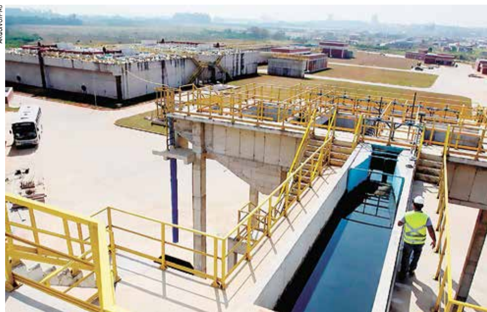
Vista geral da Estação de Tratamento de Esgoto (ETE), no Parque dos Sinos
