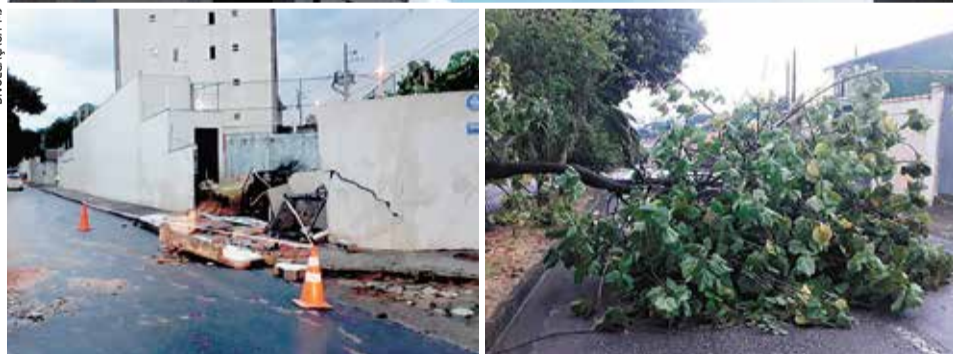
O temporal provocou estragos em bairros, derrubando muros e árvores
