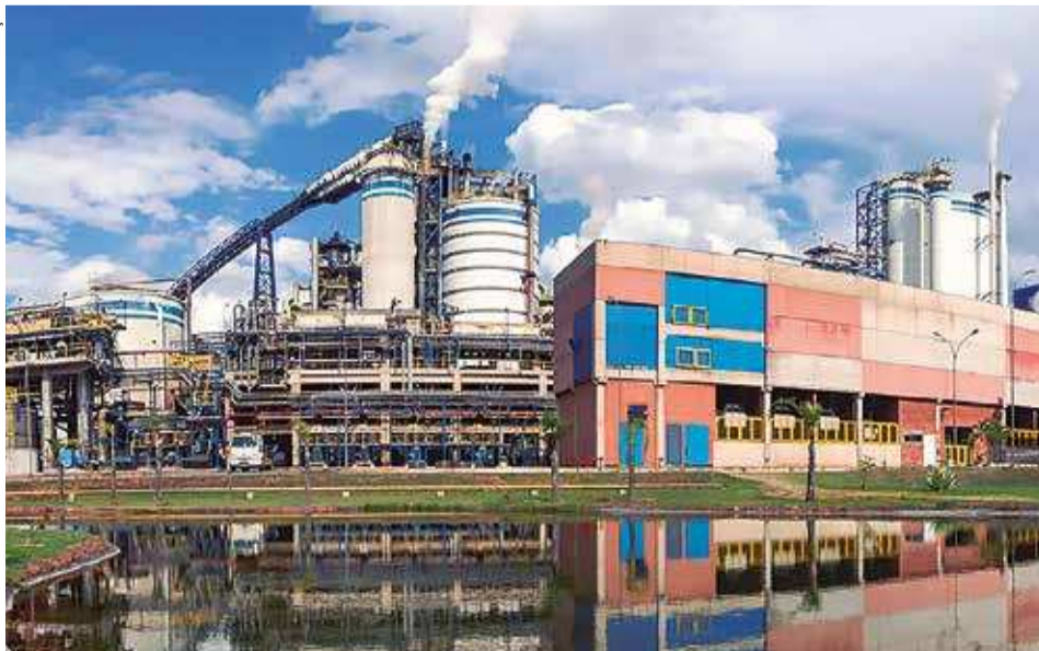
Vista parcial da unidade fabril da Suzano, no distrito São Silvestre, em Jacareí
