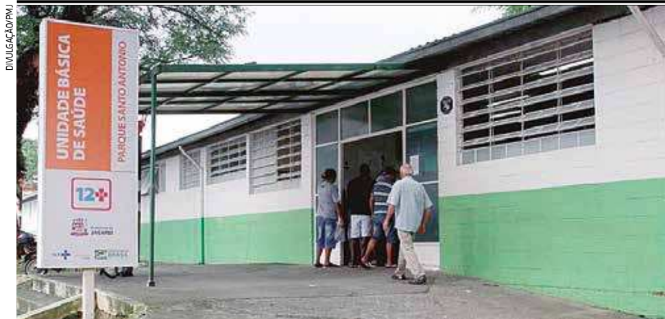
Vista externa da Unidade de Saúde do Parque Santo Antônio (região sul)
