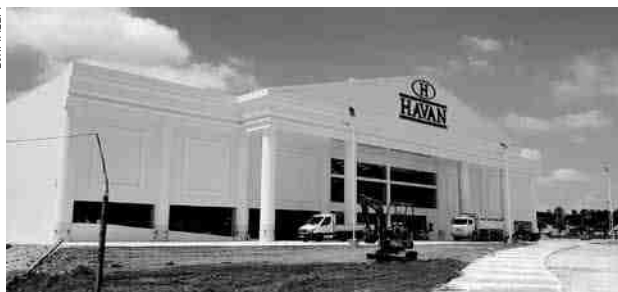
Obra de construção da loja da Havan entra na reta final
