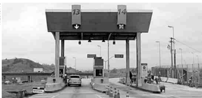
Cabine avançada de pedágio na região do bairro Nova Jacareí
