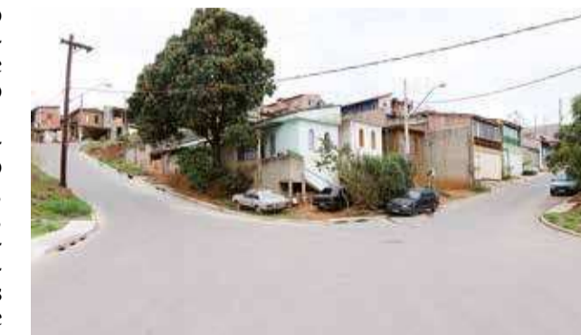
Em três anos de governo Izaias, a Prefeitura asfaltou 40 ruas, como no bairro Primeiro de Maio (acima) e Conjunto 22 de Abril (ambos na região oeste)
