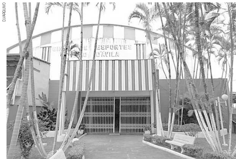
Antigo ginásio de esportes Hélio D'Ávila, que há anos está abandonado, sem manutenção e impedido de receber eventos esportivos
