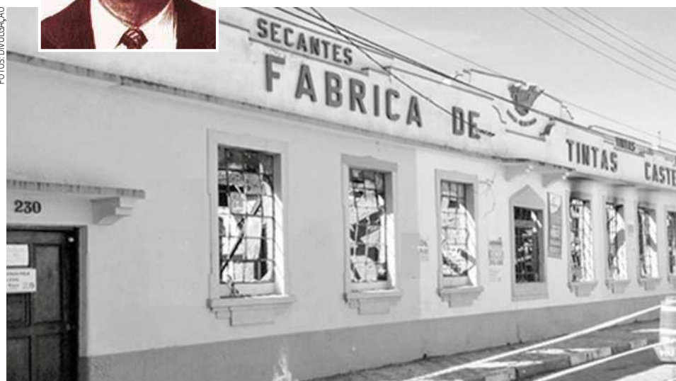
A Fábrica de Tintas Castelo, hoje demolida. No destaque acima, o pioneiro Harold Holland
