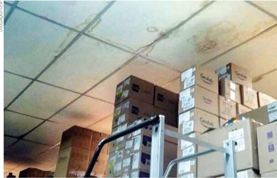
Mancha no forro da farmácia municipal proveniente de vazamento no telhado
