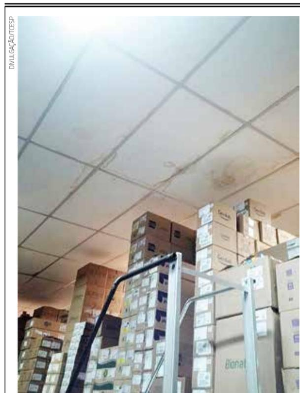
Mancha no forro da farmácia municipal proveniente de vazamento no telhado da unidade
