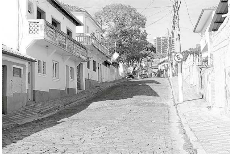
A Rua Francisco Teodoro, no centro, será uma das vias contempladas com asfalto em Jacareí
